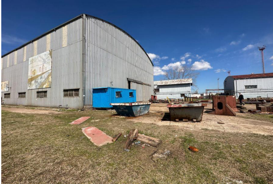
Foto 27. Vista actual hangar mecánica interna.
