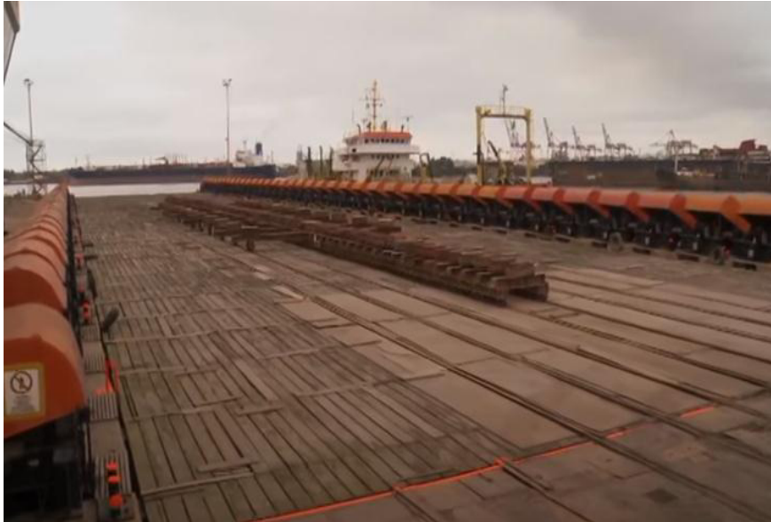
Foto 1. Vista de las camas en Syncrolift.
