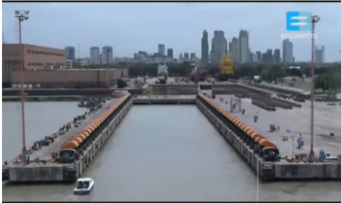
Foto 31. Vista Syncrolift sin plataforma elevada.
