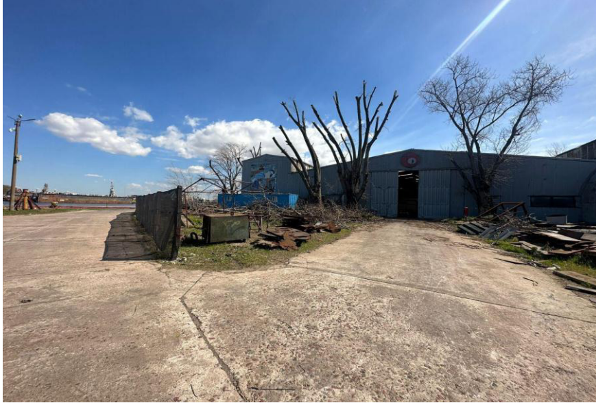
Foto 25. Vista frontal Predio Mecánica. Actual.
