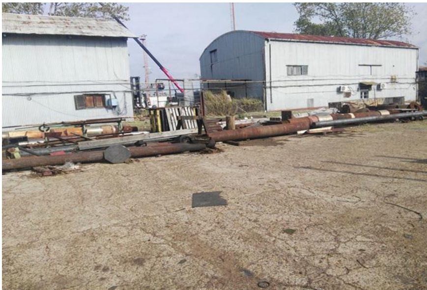
Foto 17. Mas desechos afuera de mecánica interna.
