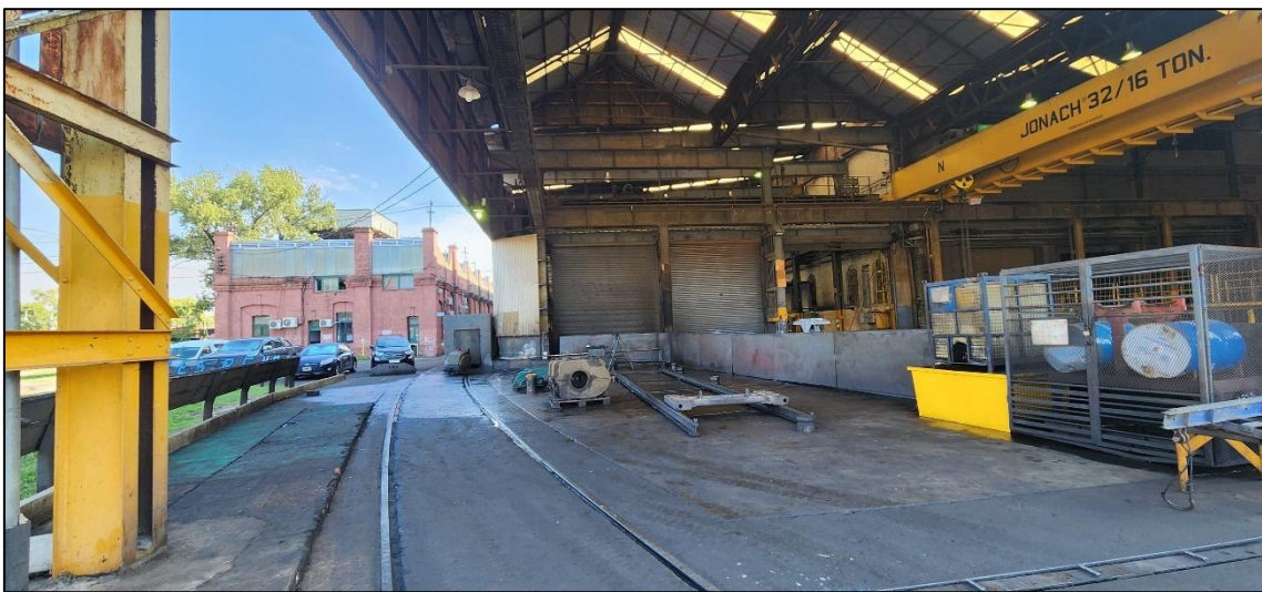
Figura 9- Sector lavado Nave 0
