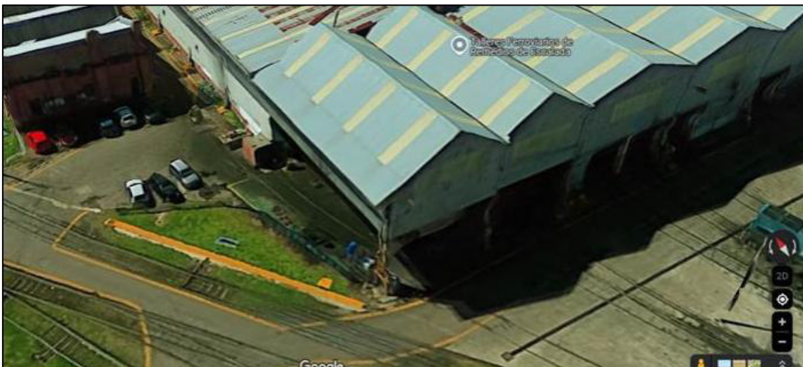
Figura 10- Vista aérea sector lavado Nave 0
