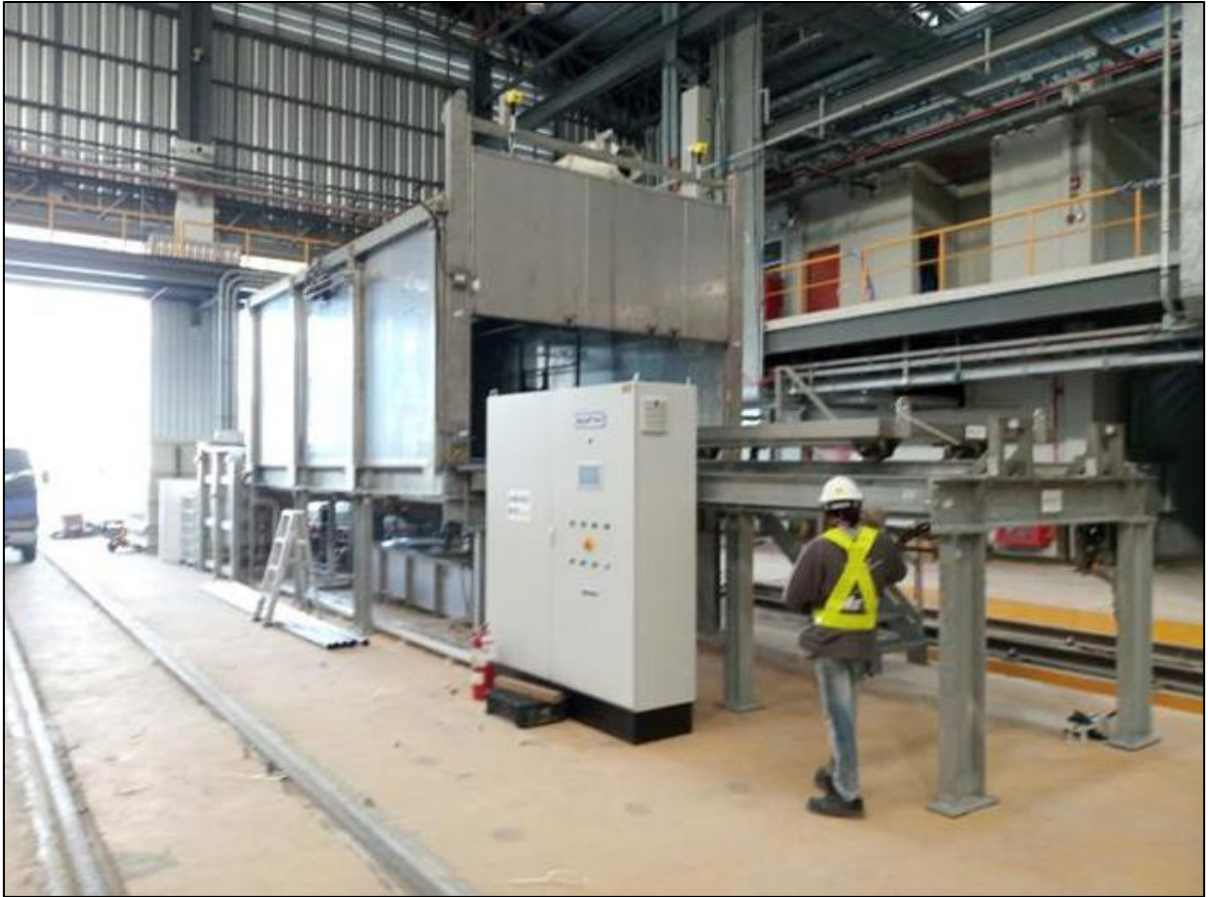
Figura 12- Cabina sobreelevada, Bangkok
