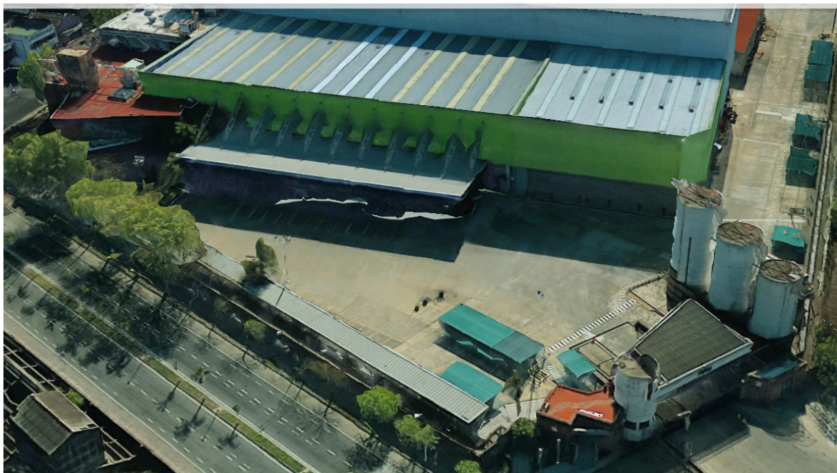
Edificio principal de Logística Telefónica
