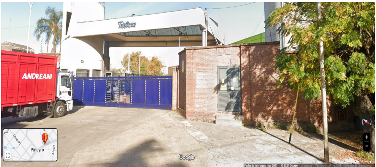
Frete del edificio de Logística Telefónica
