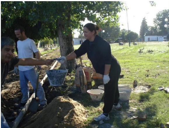
Preparación vereda : calle144
