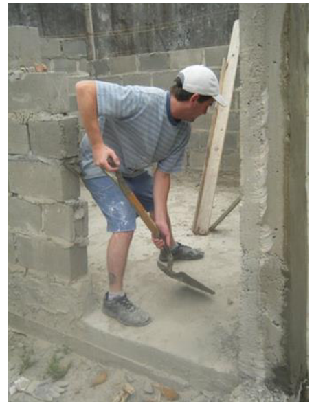
Construcción vivienda: calle 28 y 145
