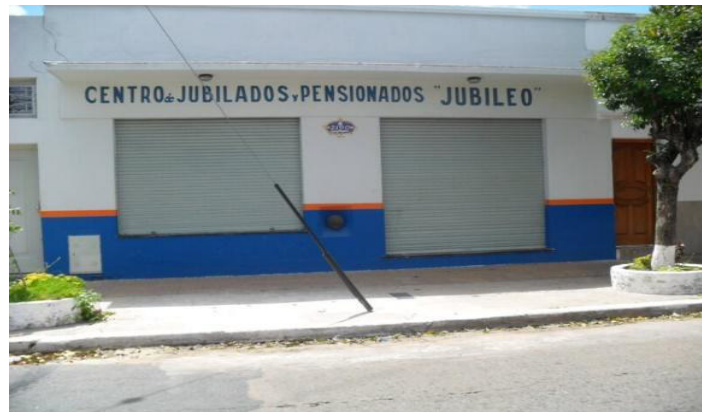
Vereda y pintura predio Centro de Jubilados: calle,141
