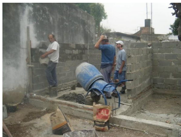
Construcción de vivienda: calle 27 y 142A
