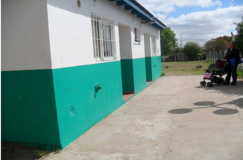
Pintura sede unidad sanitaria N°17: calle 144
