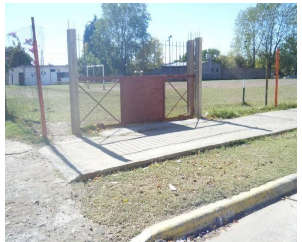
Construcción y colocación de cerco y portón Club Fimet
