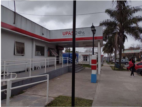
Figura 62. Vista aérea de UPA y Hospital Modular y lateral de UPA 5 (Fuente: Autoridades de UPA 5, 2024).
