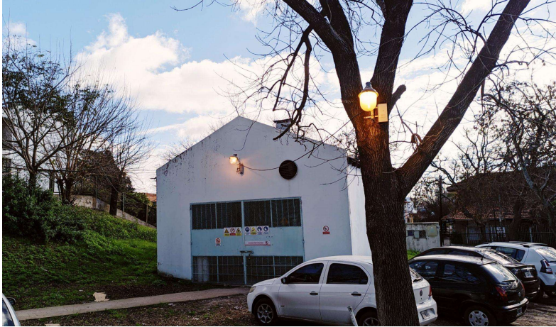
Figura 14. Edificio de la Planta de Oxígeno en el predio del estacionamiento (Fuente: elaboración propia 05/2024).
