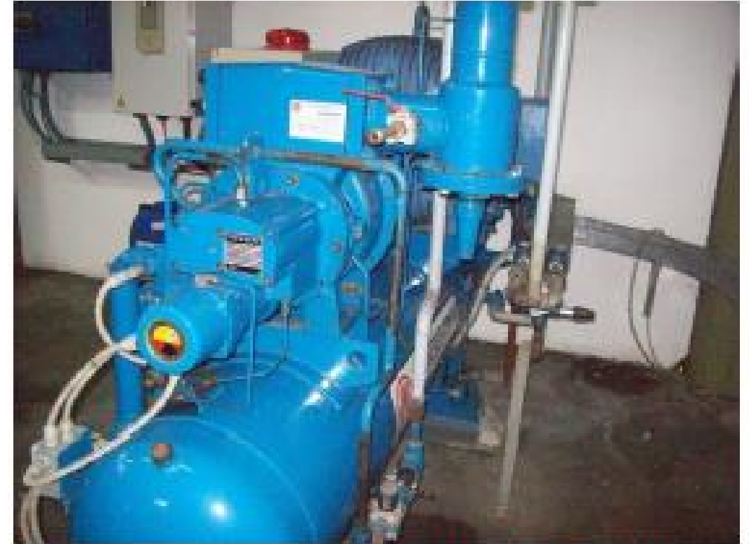
Cañería de Borrás Indesarmable – Compresor de Amoniaco sin Enfriador de Aceite
