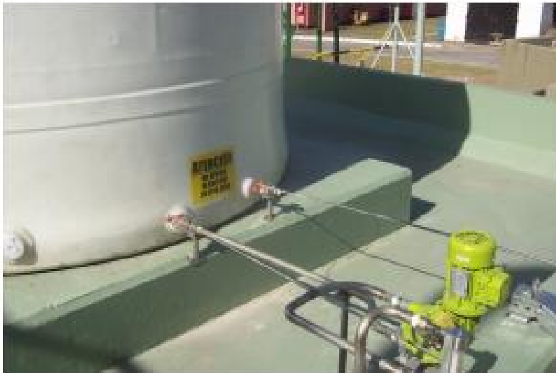
Tanque de Agua Oxigenada en Planta de Gelatina
