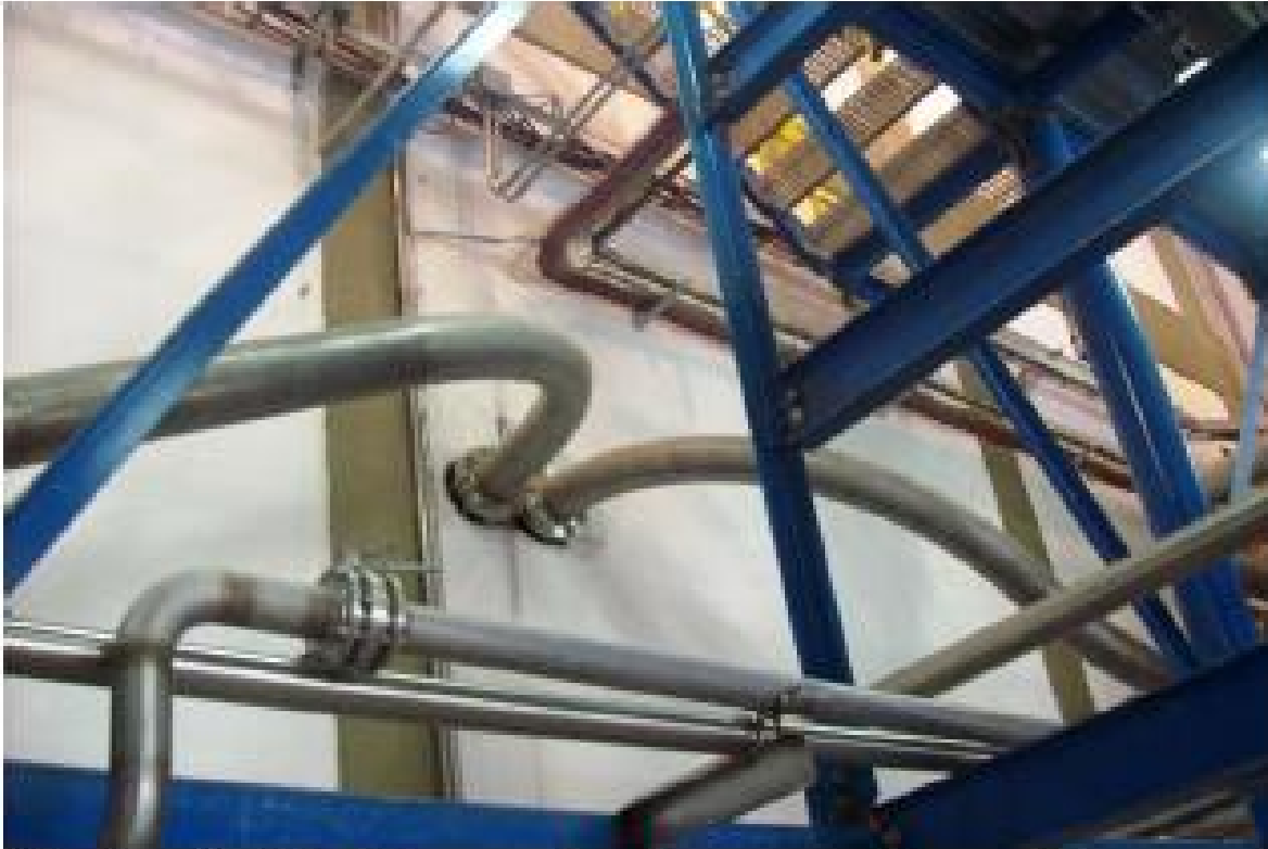
Cañería de Borrás Indesarmable – Compresor de Amoniaco sin Enfriador de Aceite
