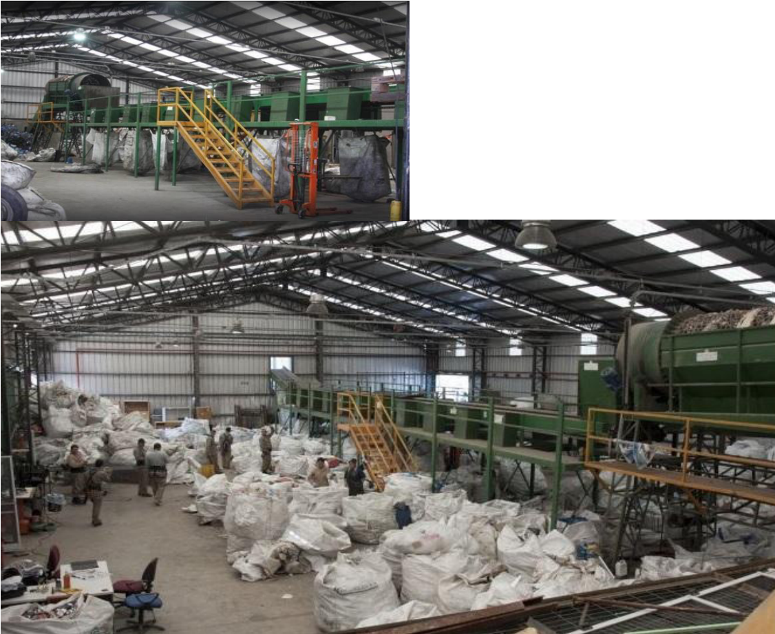
Figuras 17 Primera nave de RSU ECOPUNTO.
