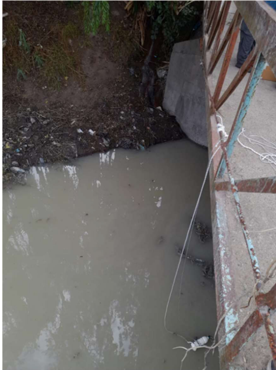
Figura 4. Puente sobre el arroyo Las Conchitas y sonda. Fuente: elaboración propia.
