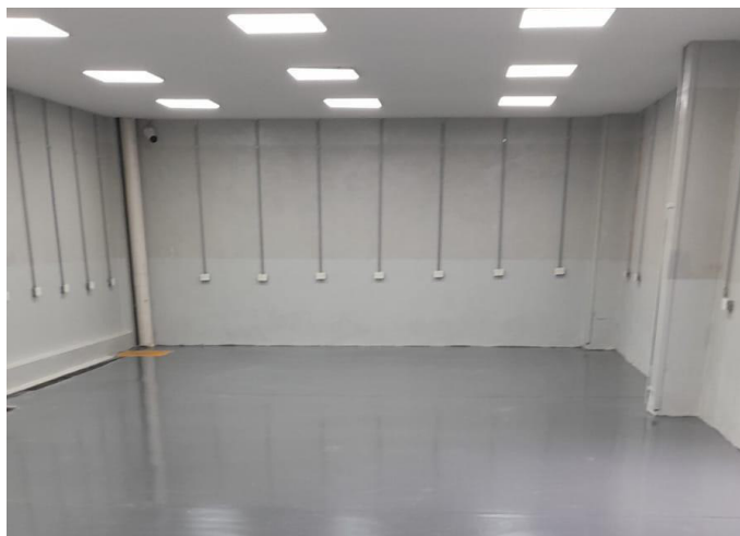
Imagen 8: Nueva sala de secado (en obra)
