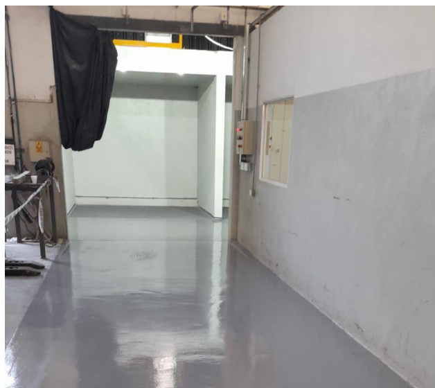
Imagen 7: Nuevo pulmón al lavadero, al fondo cubículo de lavadero en obra
